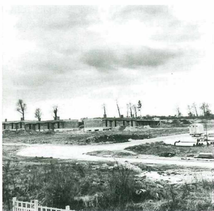
chantier des pavillons P.S.R. (programme de relogement) en 1972
